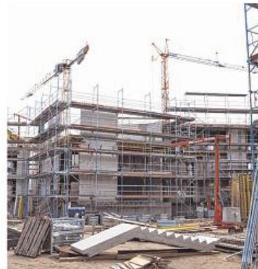
In etwa 14 Tagen wird mit der Montage der Fassade begonnen.
