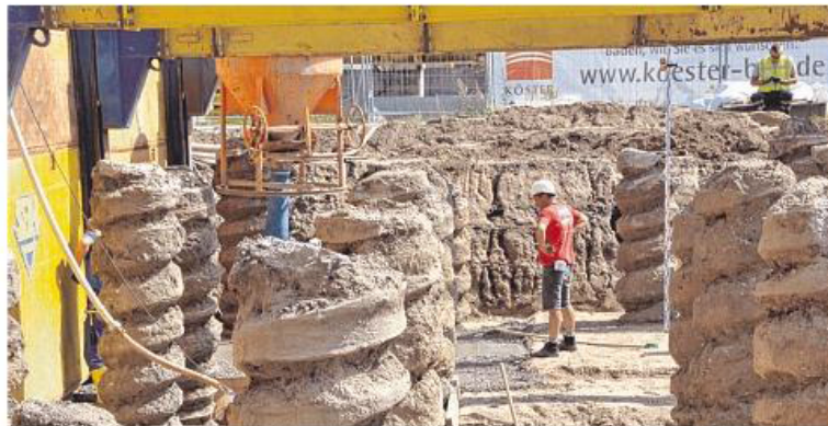
Mit Hilfe eines sogenannten Gleitschienenverbaus wird direkt neben dem Strandweg die erste Baugrube im Westen des Geländes erstellt. Die Reste der Bohrpfähle werden noch gekappt.
