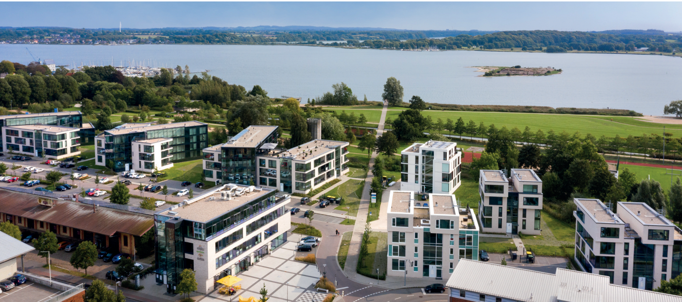
Das Quartier Königswiesen in Schleswig umfasst sieben Gebäude und wurde komplett vom Bau-Komplettanbieter Köster umgesetzt Abb.: Quelle Köster GmbH
